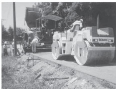
バリオマチック搭載の振動ローラーは、コンピュータ制御により、軟らかい所は強く、硬い所は弱くなど路面の締め固め状況をセンサーが感知しながら最適の振動エネルギーを路面に与え、転圧面全ての箇所において均一にする事が可能です！（水平振動・斜め振動・垂直振動の手動操作も可能です。）
